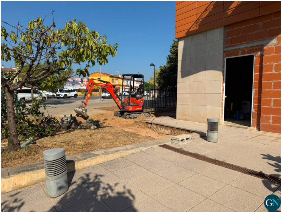
Inici obres nou local / Aj.Figueres
