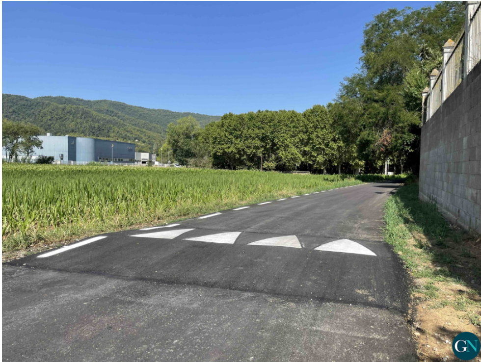
Asfaltatge Puig Fontpudosa
