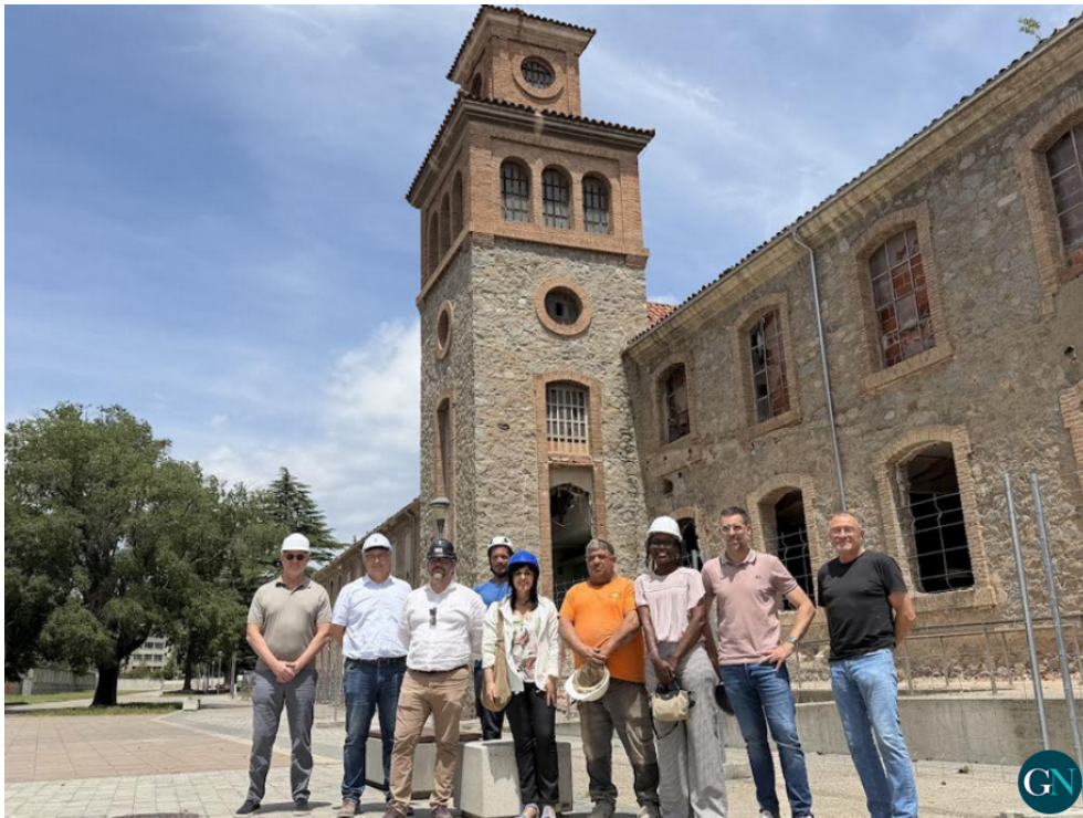
Inici d'obres / Aj.Ripoll
