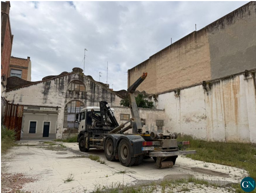
Inici obres / Aj.Figueres
