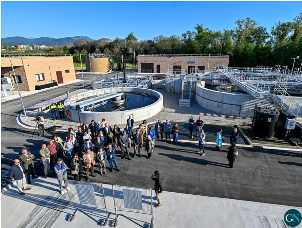
Depuradora de Sant Gregori
