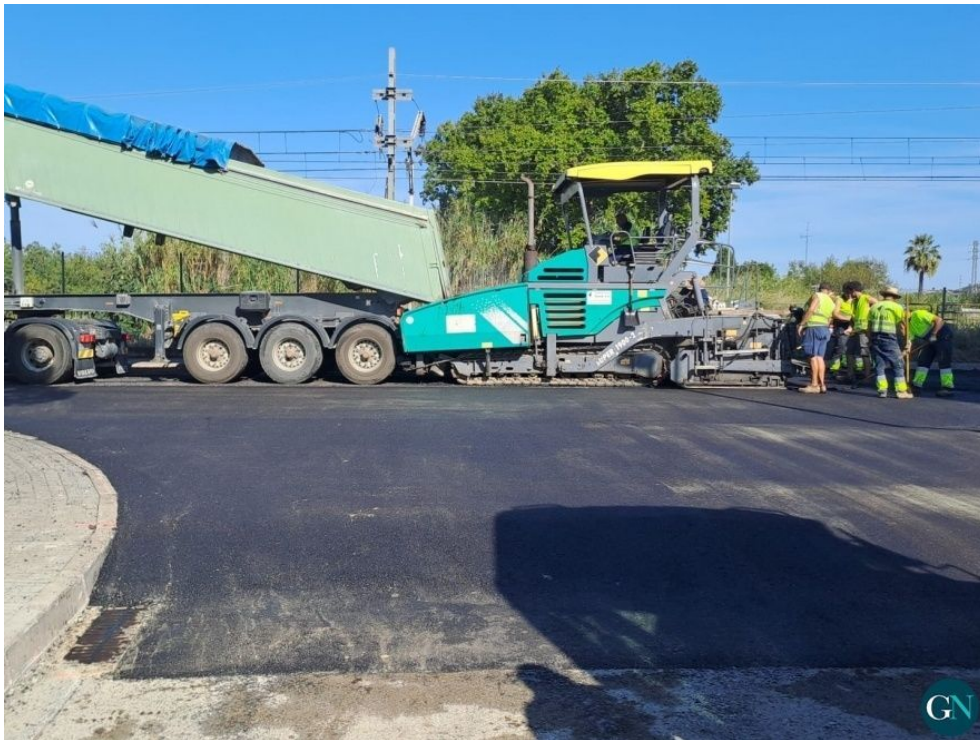
Segona fase del Pla Fem Figueres d'asfaltatge i millora de voreres / Aj.Figueres
