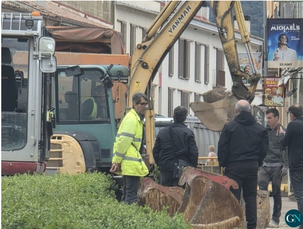
Obres al carrer Lluís Companys de Besalú / GN
