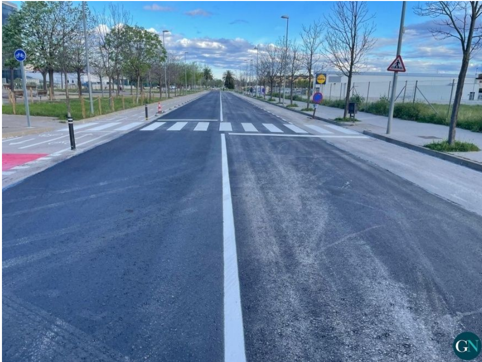
Asfaltatge de l'Av. Montserrat Vayreda / Aj.Figueres
