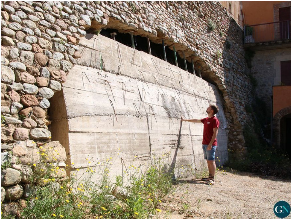
Les obres de reparació de la muralla / Acn
