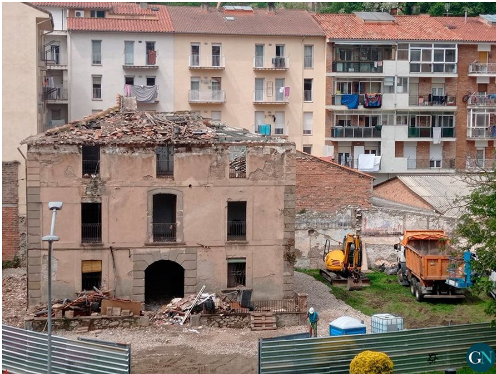
Estat de les obres a mitjans del mes de maig
