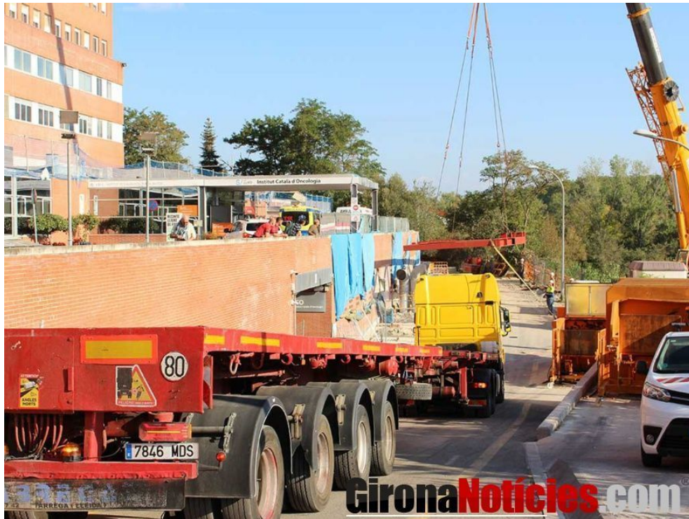
Treballs de construcció del nou edifici
