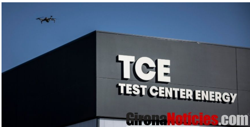
Centro de baterías SEAT
