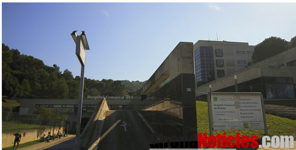
Hospital Comarcal de Blanes
