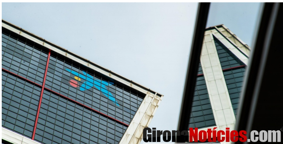
Sede corporativa de CaixaBank en Madrid - Nueva imagen
