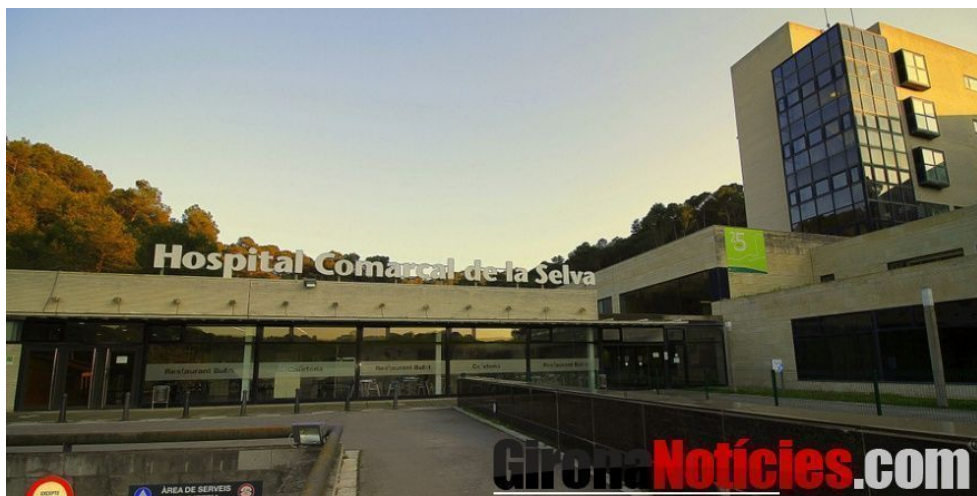
Hospital Comarcal de Blanes
