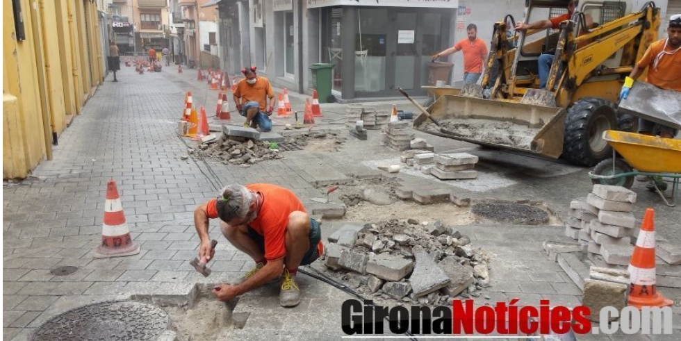
Arranjament i millora dels carrers Nou i Roda
