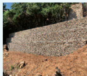
Murs de protecció a la Vila Romana
