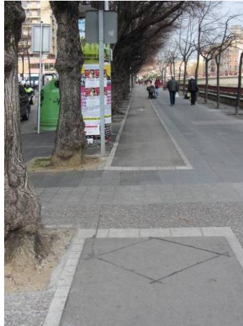
Fotografia 4.3.1.3 – Aforador automàtic d'espira en el carril bici
