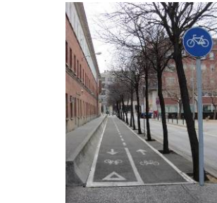
Fotografia 3.2.1.72 – La separació entre el carril bici i la vorera és en aquest cas molt clara, amb una mediana de formigó (c/ Joaquim Botet)
