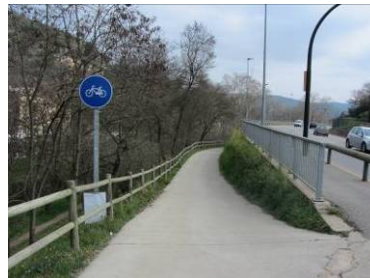
Fotografia 3.2.1.14 – Connexió de la Via Verda de Girona cap a la Creueta i Sant Feliu de Guíxols
