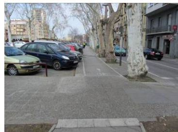
Fotografia 3.2.1.54 – Carril bici al carrer del Carme
