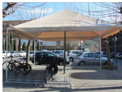
Fotografia 3.2.2.13 – Aparcament cobert a l'Hospital Dr. Trueta
