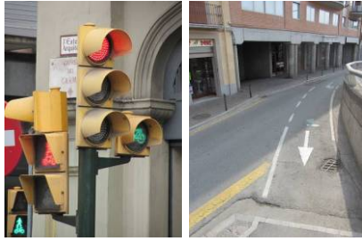
Fotografies 3.2.1.8 – Semàfor amb fase semafòrica que permet la sortida avançada de la bicicleta
