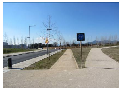
Fotografia 3.2.1.3 – Tram de carril bici en construcció, a la carretera de Sant Gregori
