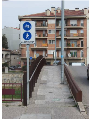
Fotografia 3.2.1.11 – Senyalització de via compartida amb el vianant, on hi ha xarxa de carrils bici però no suficient espai (Font del Rei)
