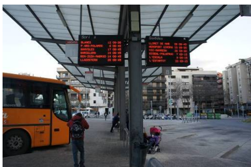
Fotografia 3.3.2.1 – Andanes de l'estació d'autobusos de Girona
