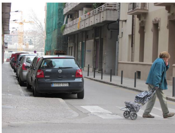
Fotografia 3.1.7.1 – Gual deprimat i 'orella' que millora la visibilitat (a la vegada que minimitza el tram de calçada a superar pel vianant), al carrer Ibèria amb Santa Eugènia
