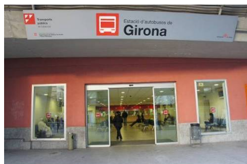
Fotografia 3.3.2.2 – Accés al vestíbul de l'estació d'autobusos
