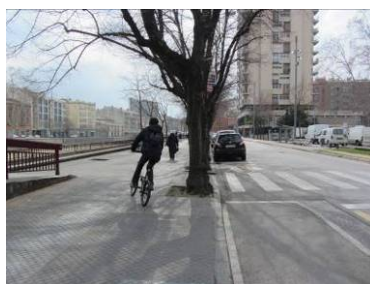
Fotografia 3.2.1.21 – Manca de continuïtat del carril bici, envaint pas de vianants (Pg. General Mendoza)
